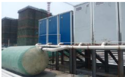
图 5-2 施工现场临时卫生间
