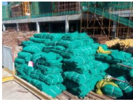
图 5-7 施工物料整齐堆放
