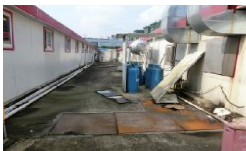
图 5-5 施工营地隔油池
