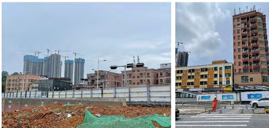
图 5.2-1 施工期降噪措施（施工围挡）
