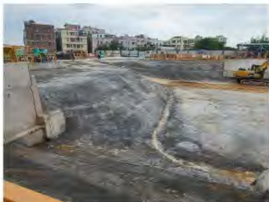
施工期临时地表硬化
