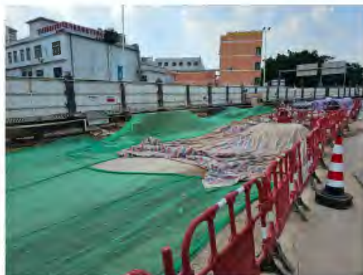
裸露地表覆盖
